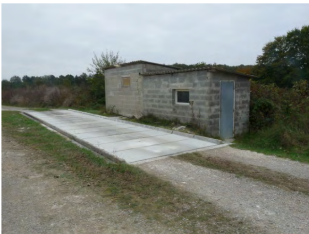
Photo 3 : Bureau, sanitaires et pont bascule
